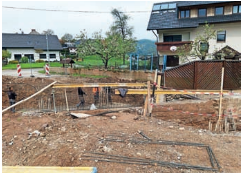
Na Gorenji Dobravi bodo v sklopu poplavalne sanacije na novo zgradili dva mostova.
