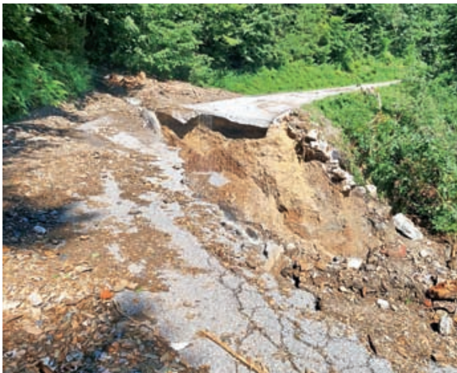
Plaz, ki je spodkopal cesto iz Srednje vasi na Brda FOTO: ARHIV OBČINE
