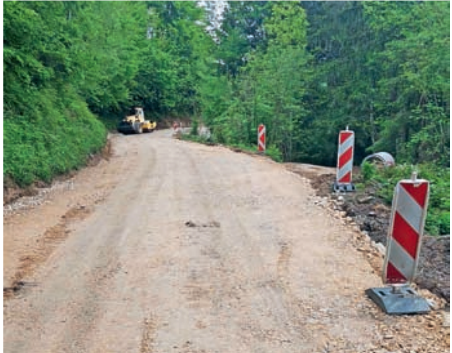
Sanacija cestišča proti Brdom FOTO: ARHIV OBČINE
